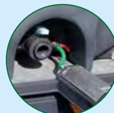
Tränkeanschluss mittels Montage-Set und Niederdruckventil
