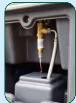
Heizsonde 24V - 12W bei Mod. 372 inkludiert
